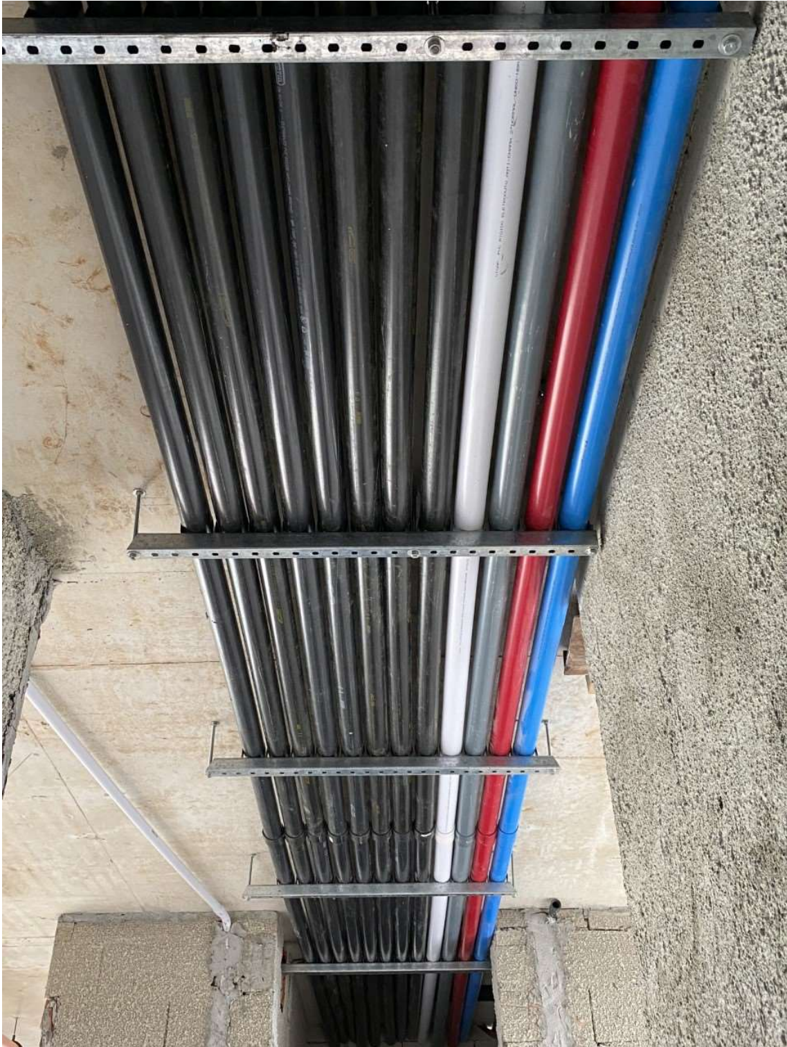
Dutos de elétrica e dos sistemas do pavimento superior
